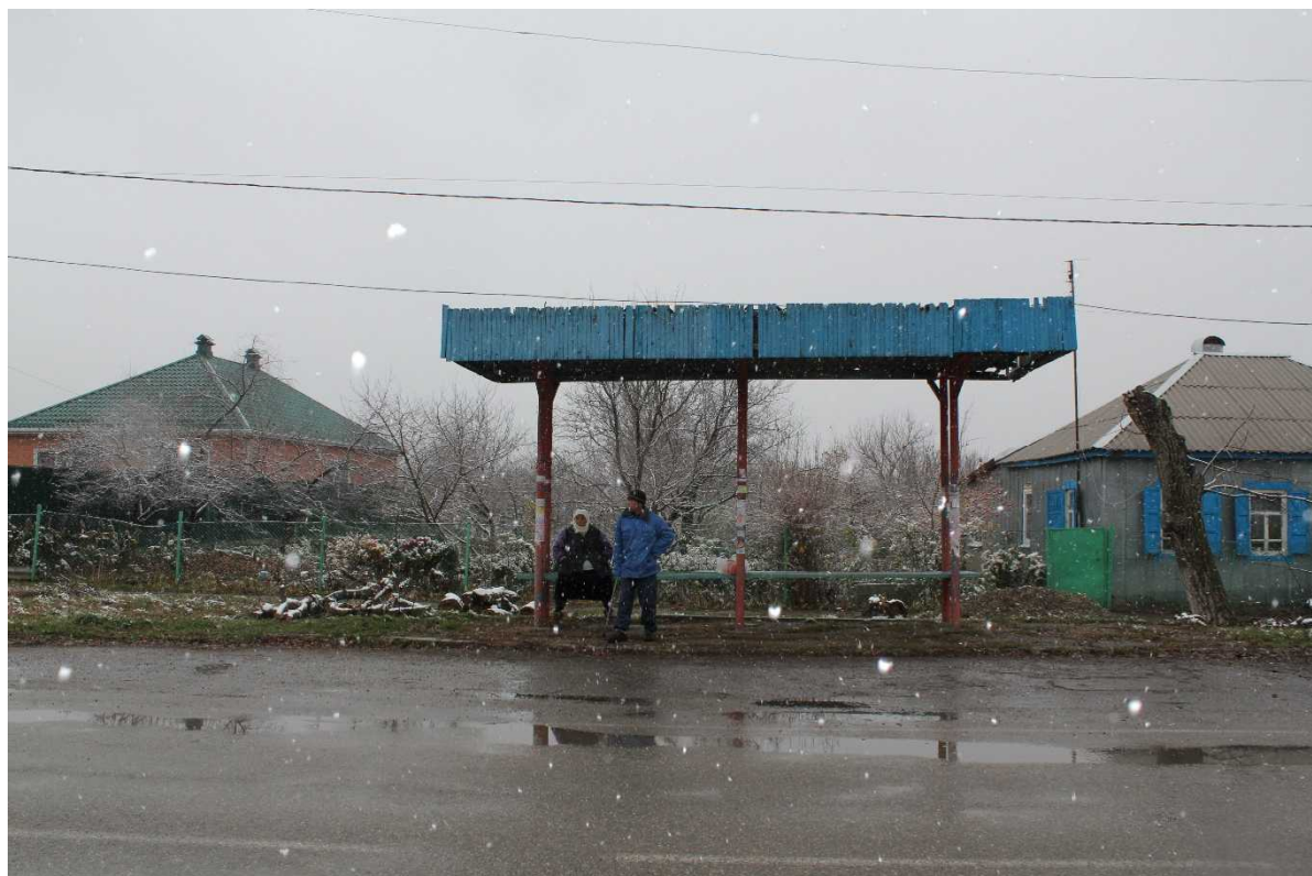
Состояние и общий вид инфраструктуры остановочной стоянки (ул.Красная-между-Эскадронной-и-Кооперативной)
