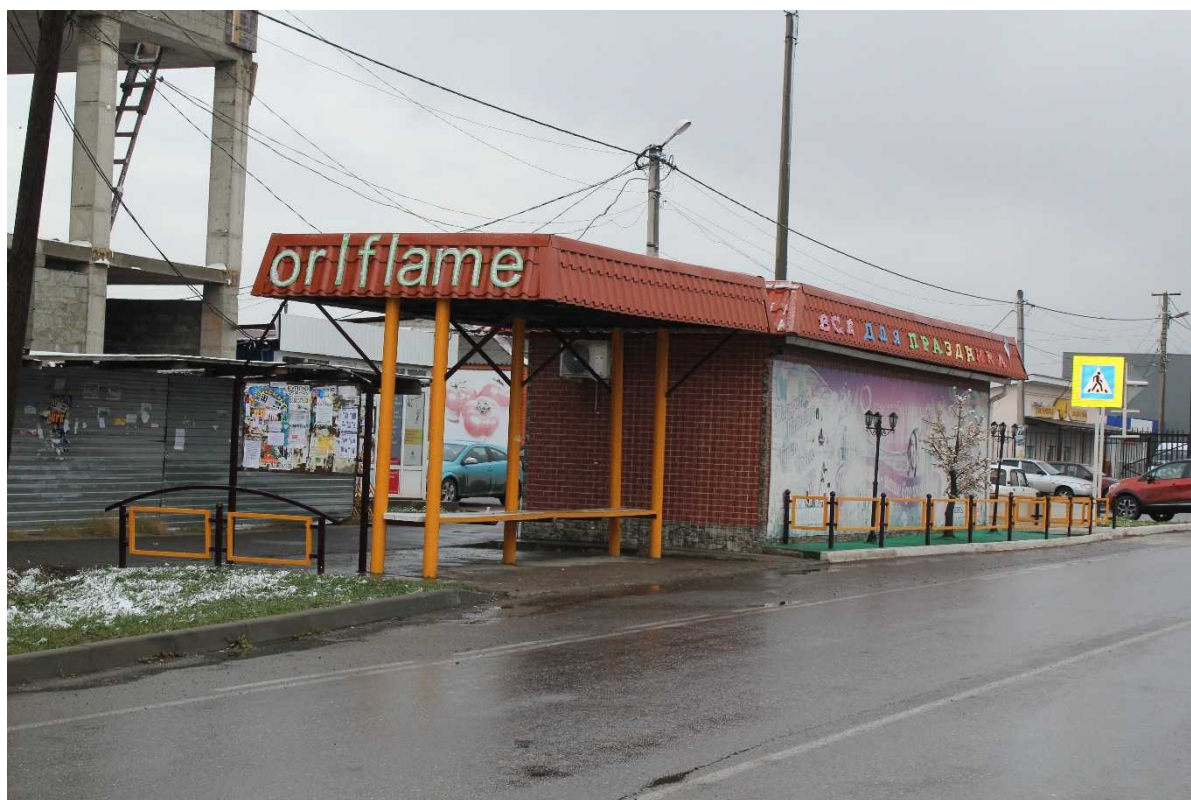
Внешний вид и состояние остановки № 20
