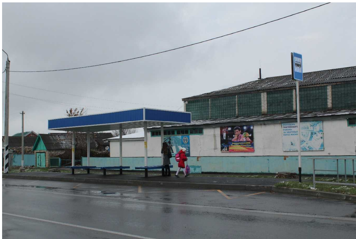
Внешний вид и состояние инфраструктуры остановки № 24
