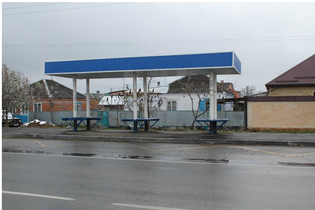
Внешний вид и состояние инфраструктуры остановки № 21
