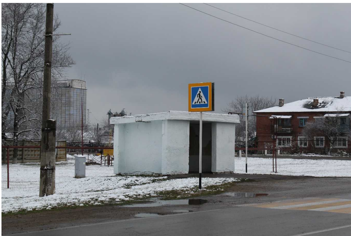
Внешний вид и состояние инфраструктуры остановки № 36
