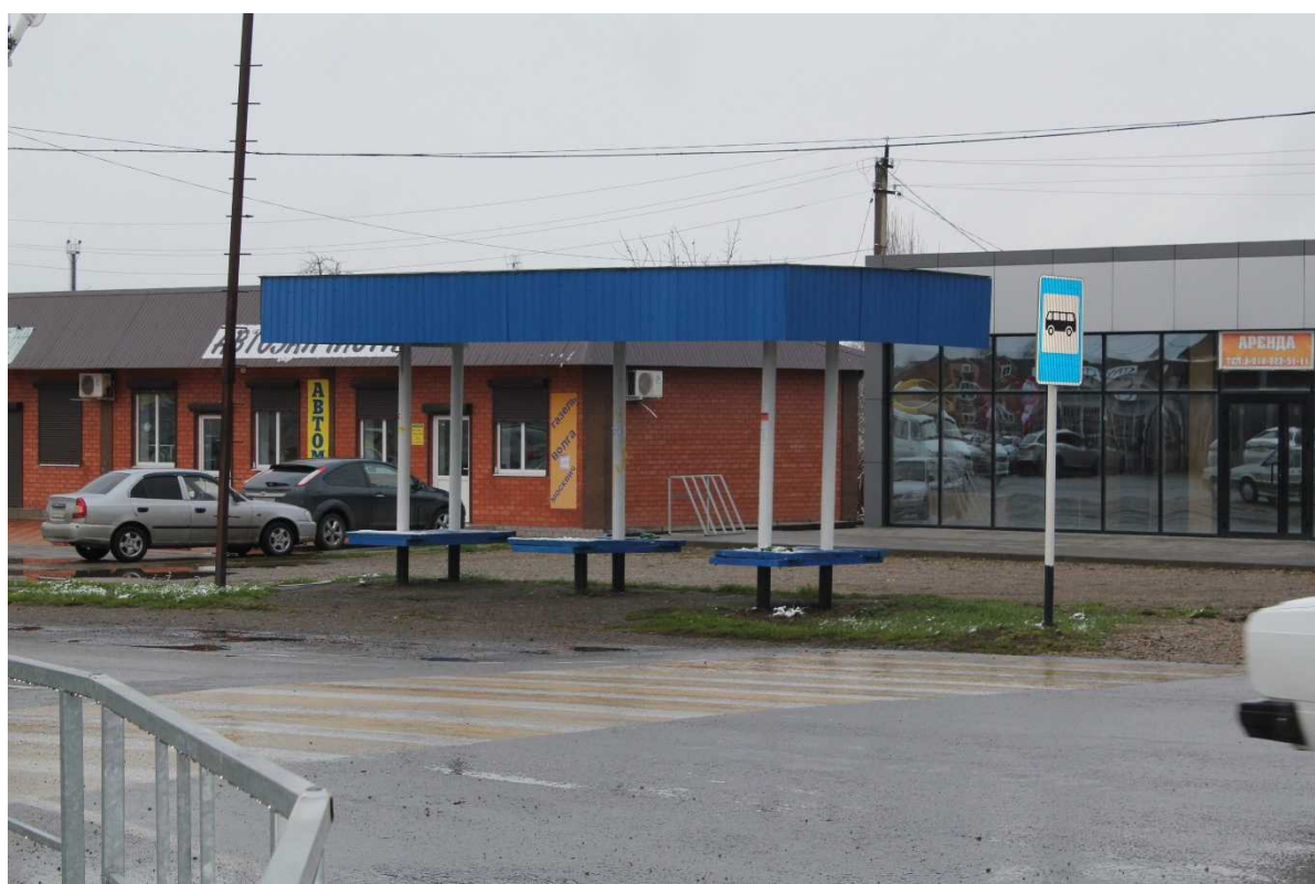
Внешний вид и состояние инфраструктуры остановки № 29
