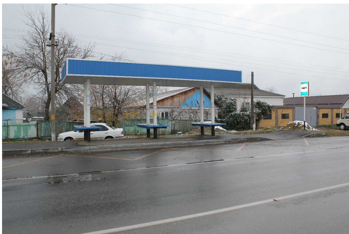
Внешний вид и состояние инфраструктуры остановки № 25
