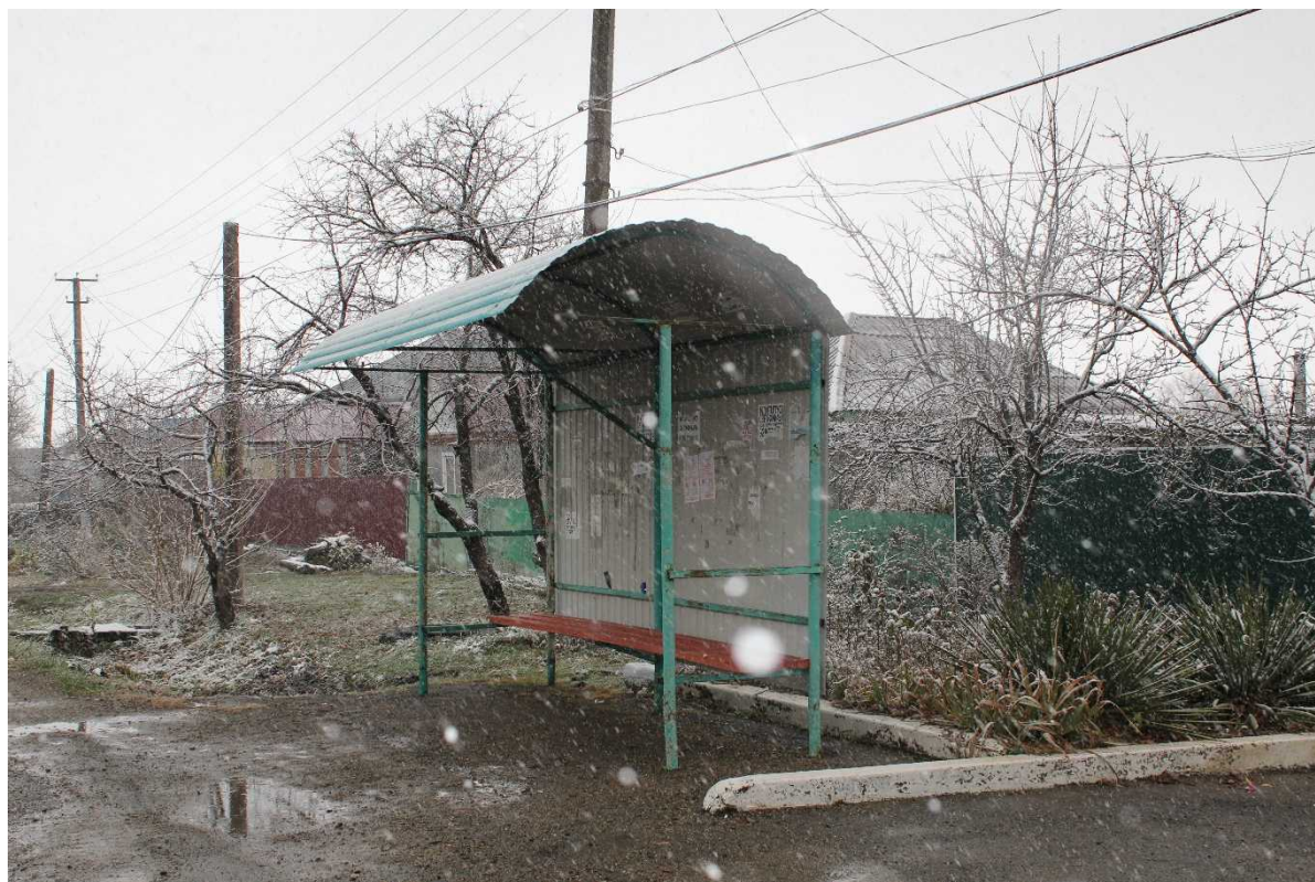
Состояние и внешний вид остановки № 08 ул.Красная
