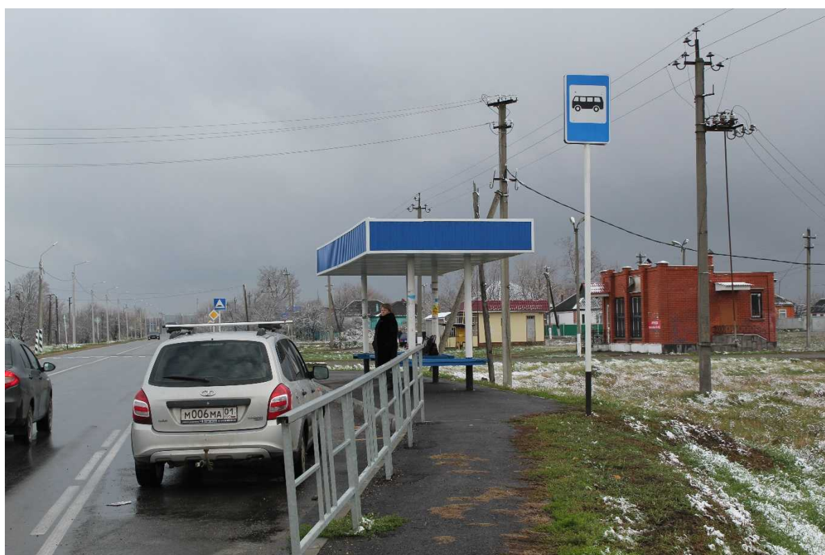
Внешний вид и состояние инфраструктуры остановки № 23
