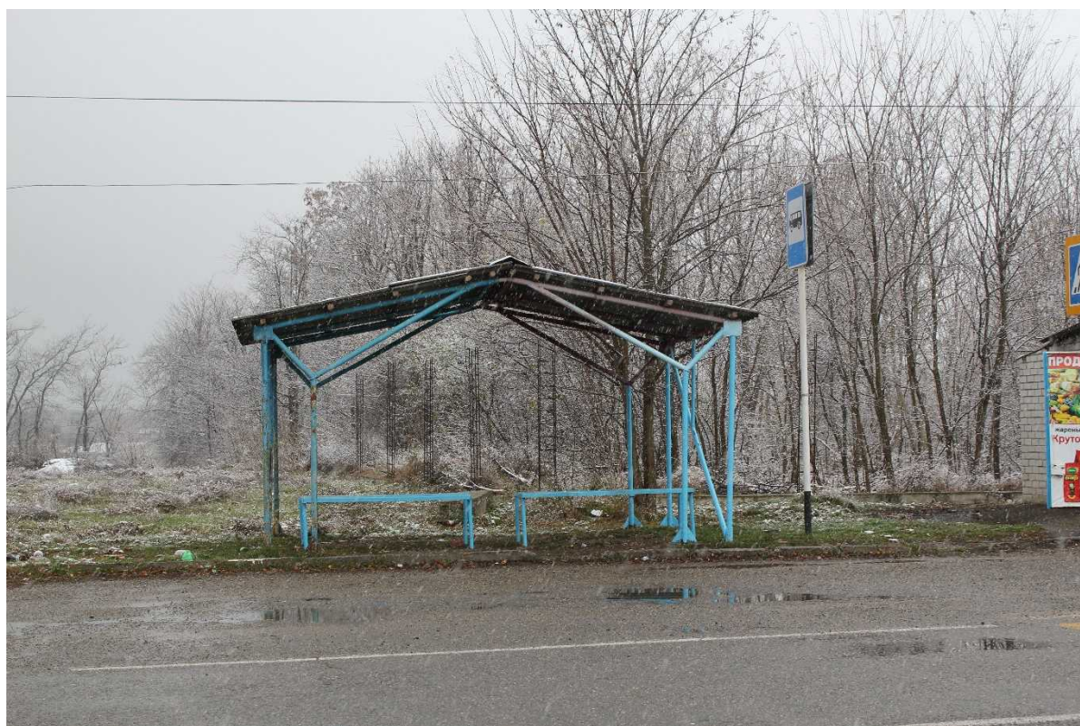
Состояние и внешний вид остановки № 11 ул. Набережная
