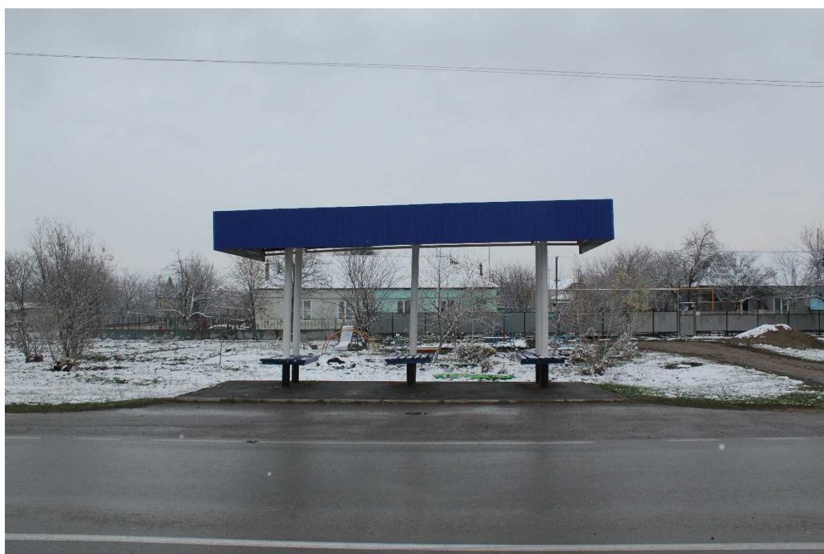
Внешний вид и состояние инфраструктуры остановки № 34
