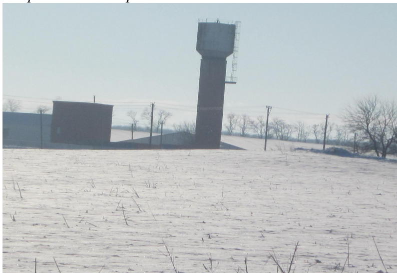
Водонапорная башня. х.Прогресс.
