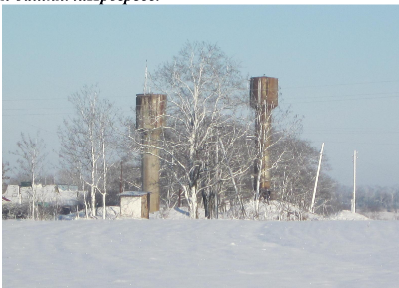
Водонапорные башни. х.Прогресс. Ржавые.
