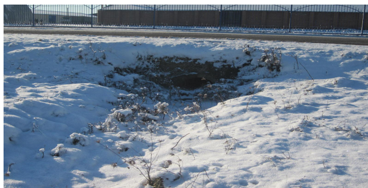
Водоотведение. с.Нижний Айрюм.
