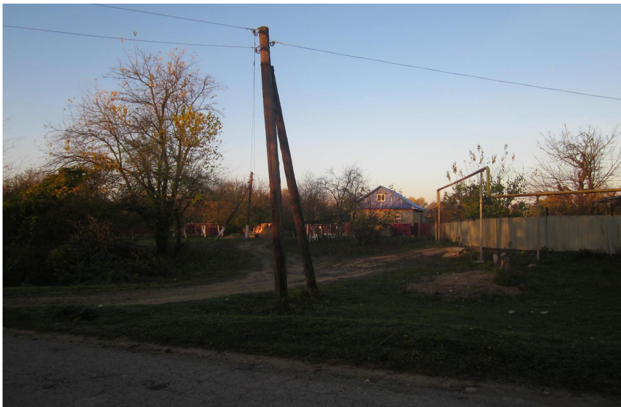
Опора линий электропередач. ул.Пролетарская. Опора деревянная.
