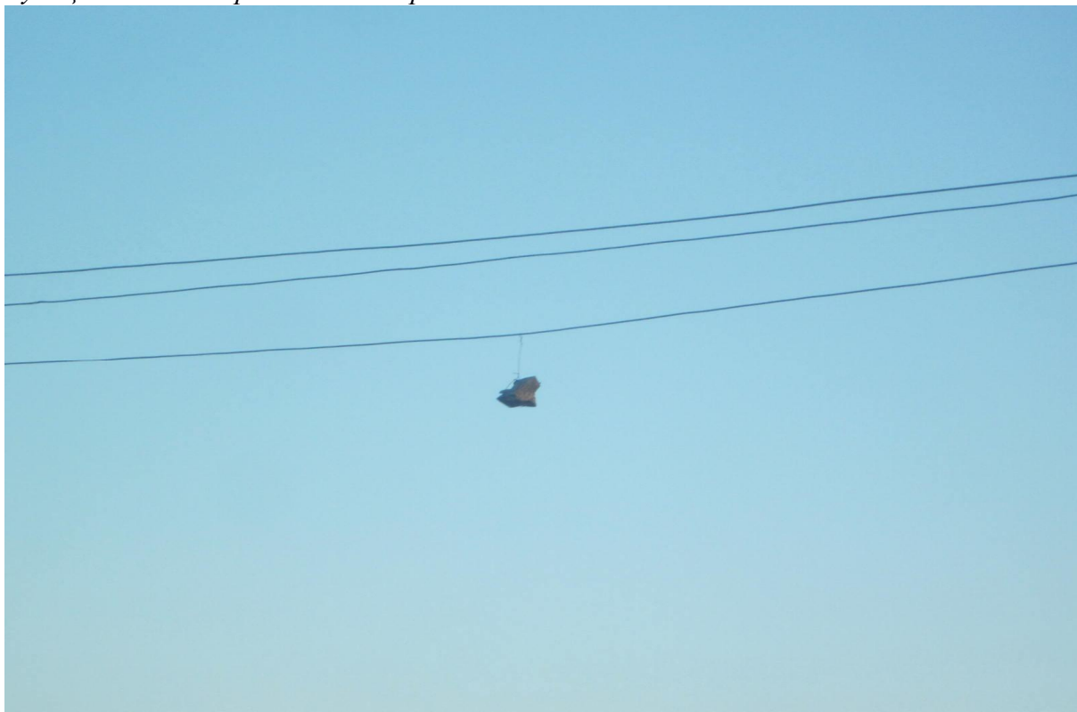
Линии электропередач. ул.Пролетарская-Конечная. На провода висит кирпич.
