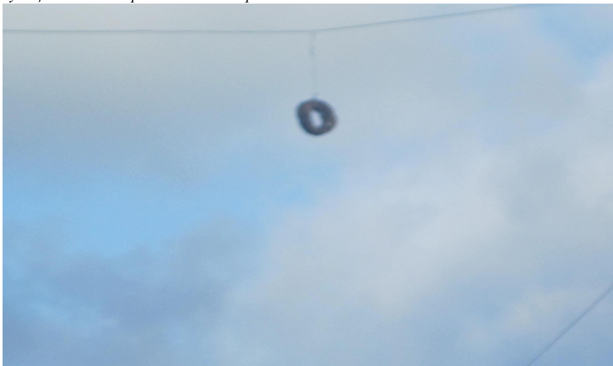
На проводах висит обмоток с двигателя. ул.Лесная.
