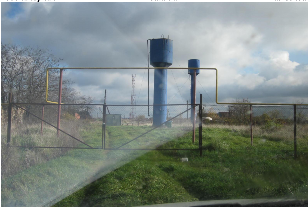
Водонапорные башни. Работает одна.
