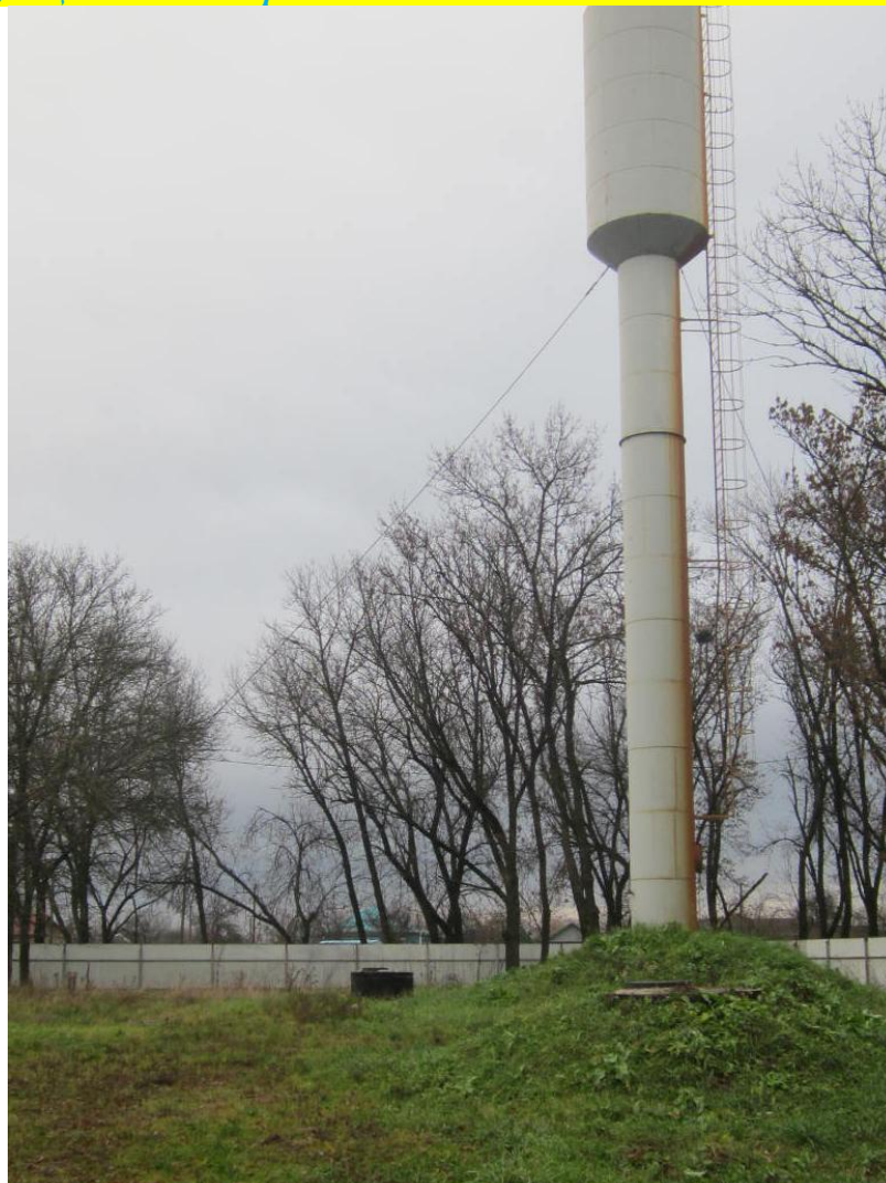
Водонапорная башня. Требованиям СНиП соответствует.
